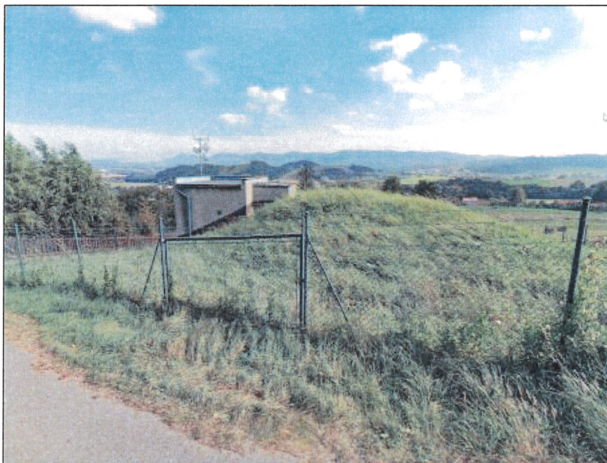
Obr.1 Celkový venkovní pohled na vodojem Stráník – nadzemní zděná část armaturní komory s navazující zděnou nadstavbou vstupu do akumulární komory
